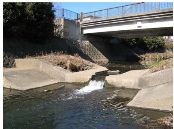
写真-3 ST.14（鍋屋橋）の落差工
