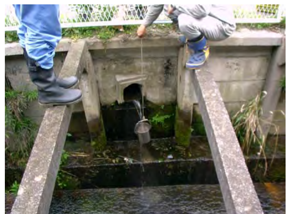
川島町湧水(保土ヶ谷区)
