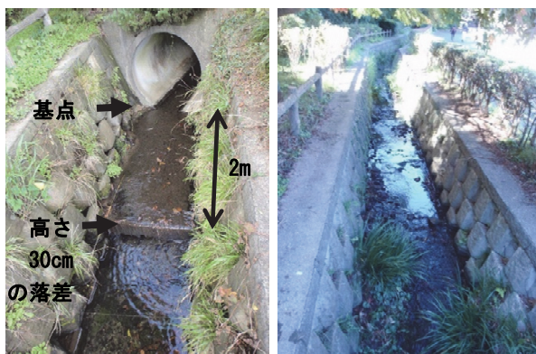
a-1) 水路最上流部 (2015年11月17日撮影)
