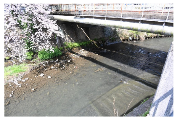
付図 7 帷子川水系帷子川両郡橋
