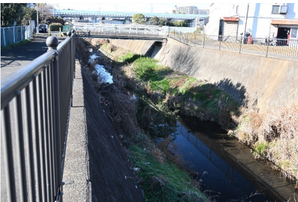
付図 3 鶴見川水系大熊川大熊下橋
