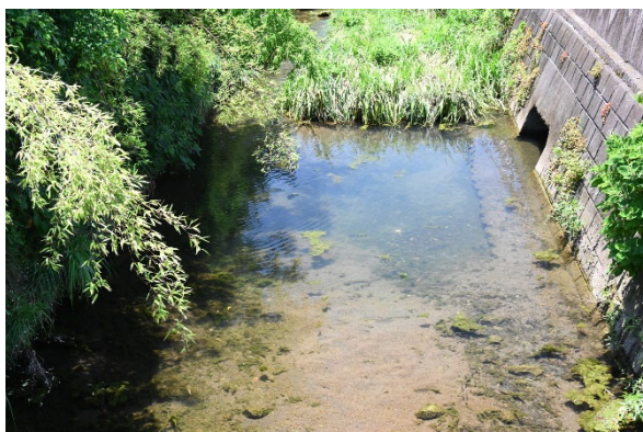
付図 12 侍従川水系侍従川加倉橋
