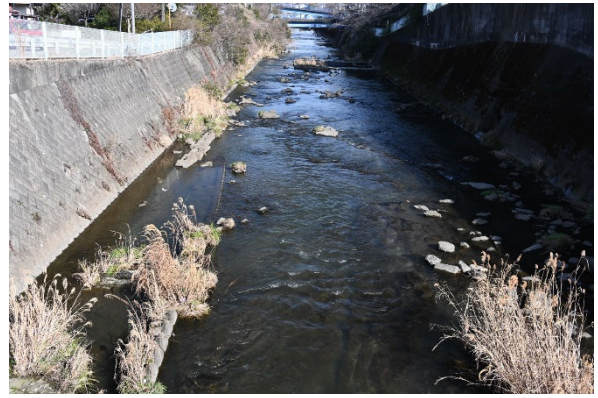
付図 5 帷子川水系帷子川鶴舞橋
