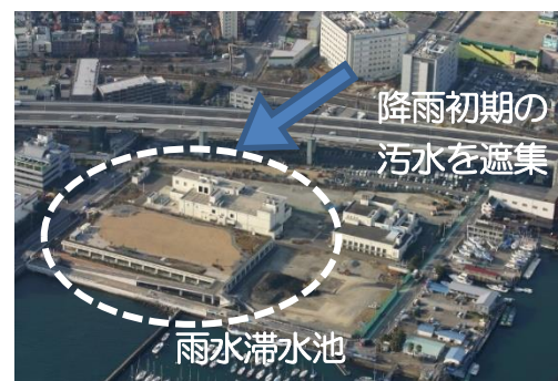
図 1-7 雨水滞水池の整備の状況 (磯子第二ポンプ場)
