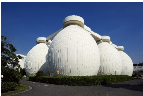
図 1-9 卵形消化タンク (北部汚泥資源化センター)
