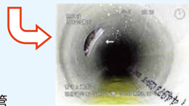
下水道管の更新工事
