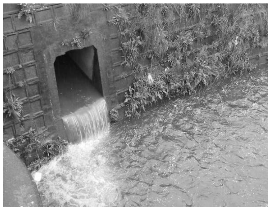
写真1.1.2.1 雨水吐から流出する未処理下水（大岡中里橋付近）
