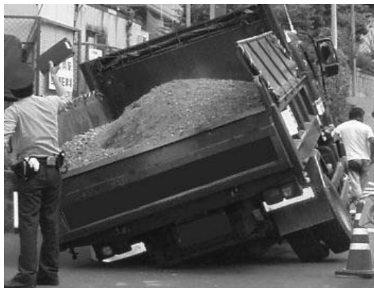
写真1.1.4.1 下水管の破損による道路陥没事故(横浜市内)
