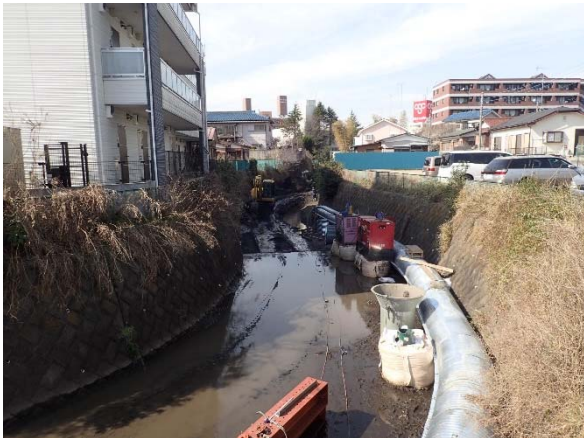
写真2 下水道管の布設状況
