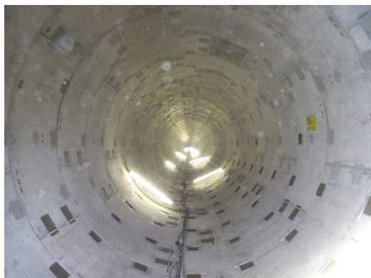
写真－1 φ3250mm シールド施工
