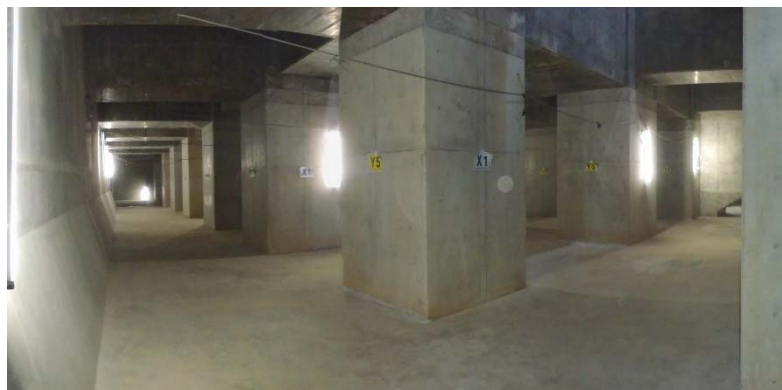
写真－2 蒔田雨水調整池の竣工写真
