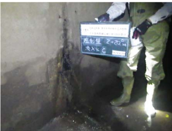
写真-2 管路内調査
