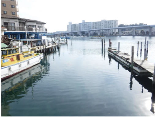
二級河川 宮川 (金沢区)
