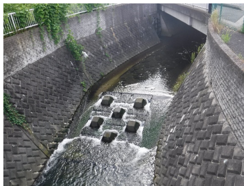
二級河川 今井川 (保土ヶ谷区)
