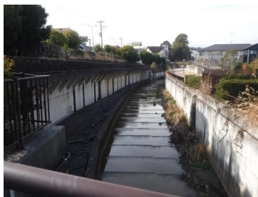
二級河川 今井川 (保土ヶ谷区)
