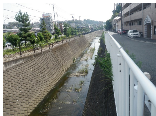
二級河川 今井川 (保土ヶ谷区)
