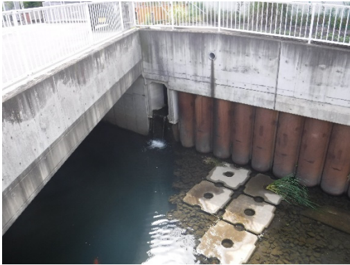
二級河川 今井川 (保土ヶ谷区)
