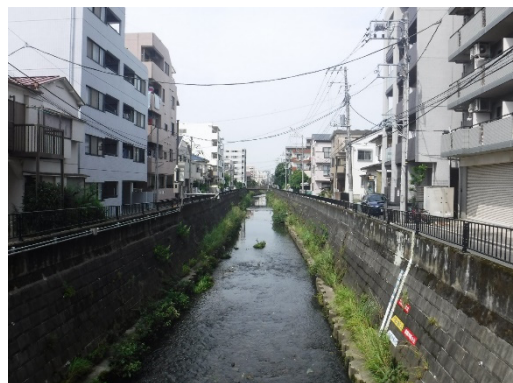
二級河川 今井川 (保土ヶ谷区)
