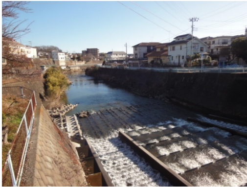
二級河川 帷子川 (旭区)
