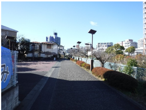
二級河川 帷子川 (旭区)
