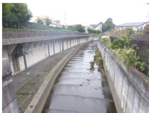
二級河川 今井川 (保土ヶ谷区)
