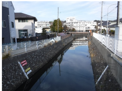
二級河川 宮川 (金沢区)
