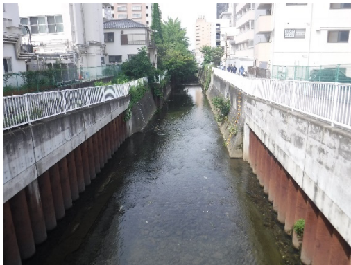
二級河川 今井川 (保土ヶ谷区)
