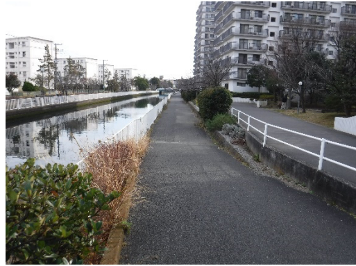
二級河川 宮川 (金沢区)
