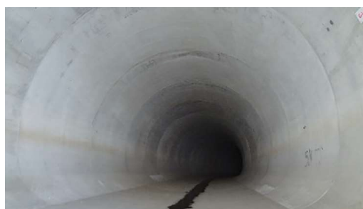
▲帷子川分水路のトンネル内部
