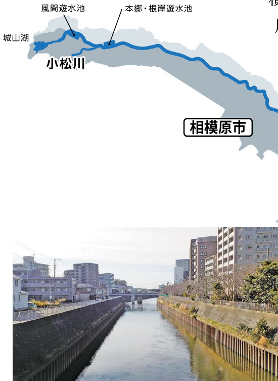
▲柏尾川合流点付近 (写真提供：神奈川県)
