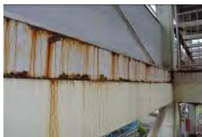
鉄骨の腐食
