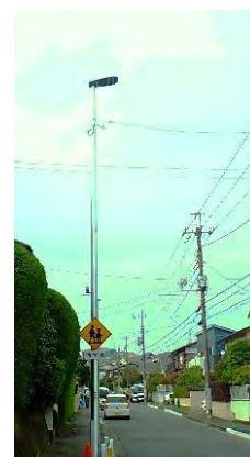
道路照明 (導入推進中)
