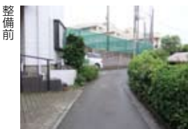
狭い道路拡幅整備（唐沢）
