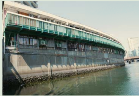
大岡川からの都橋商店街ビル
