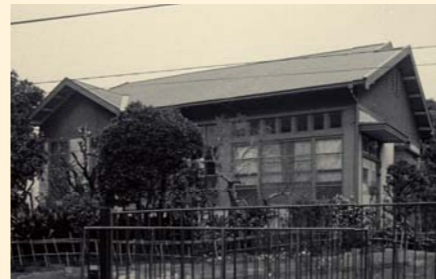
加層ノ上に建設された外国人市営住宅
