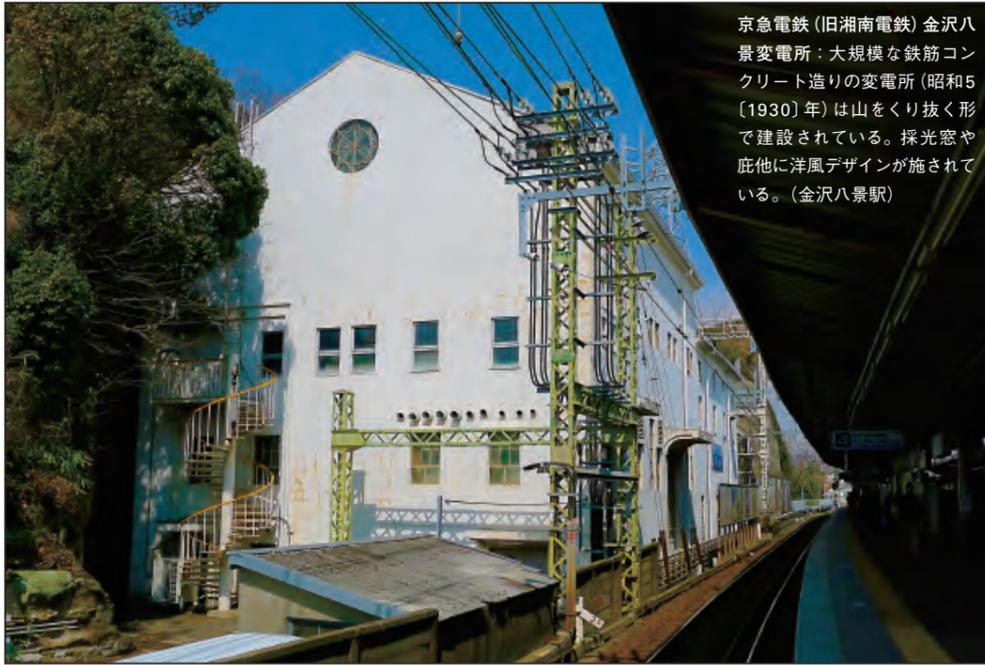
京急電鉄（旧湘南電鉄）金沢八景変電所：大規模な鉄筋コンクリート造りの変電所（昭和5〔1930〕年）は山をくり抜く形で建設されている。採光窓や庇他に洋風デザインが施されている。（金沢八景駅）
