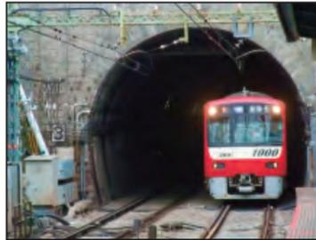
京急電鉄（旧京浜電鉄）：コンクリートブロックを使用した大断面の複線トンネル（昭和5年）は全国でも稀な存在。（日ノ出町駅）
