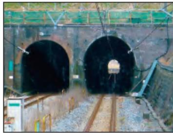
東海道本線清水谷隧道：明治22〔1889〕年に全通した東海道本線開業時から使用されている貴重な隧道。美しい煉瓦造。電化工事に伴い断面形状が一部変更されているが、ほぼ原形を保っている。（保土ヶ谷—戸塚間）
