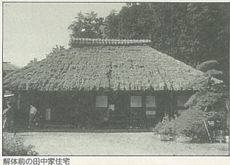
解体前の田中家住宅
