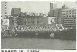
港三号橋梁(旧大岡川橋梁)
