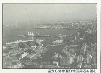
空から海岸通り地区周辺を望む
