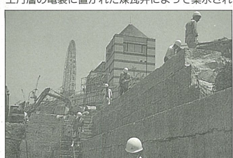
解体工事中の2号ドック
