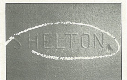
浦舟水道橋に使用された鉄材の刻印。イングランド・シェルトン社製を示している
