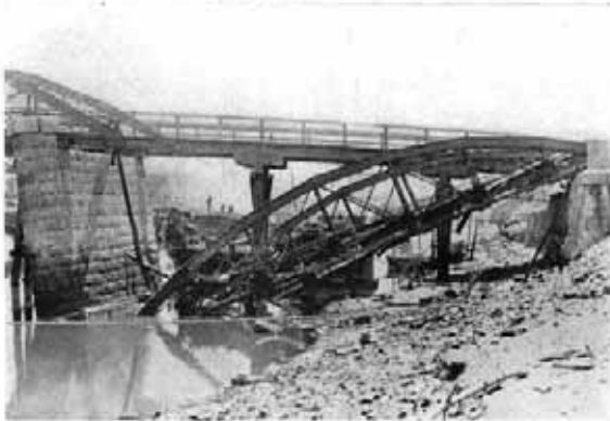
横浜市 豊国橋脚部被害状況
