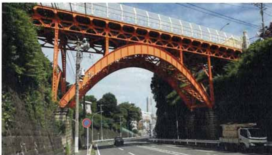
打越橋（現存）＜長さ：38.5m、幅：7.3m＞ （横浜市認定歴史的建造物、選奨土木遺産）
