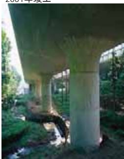
PC中空床版連続ラーメン橋
