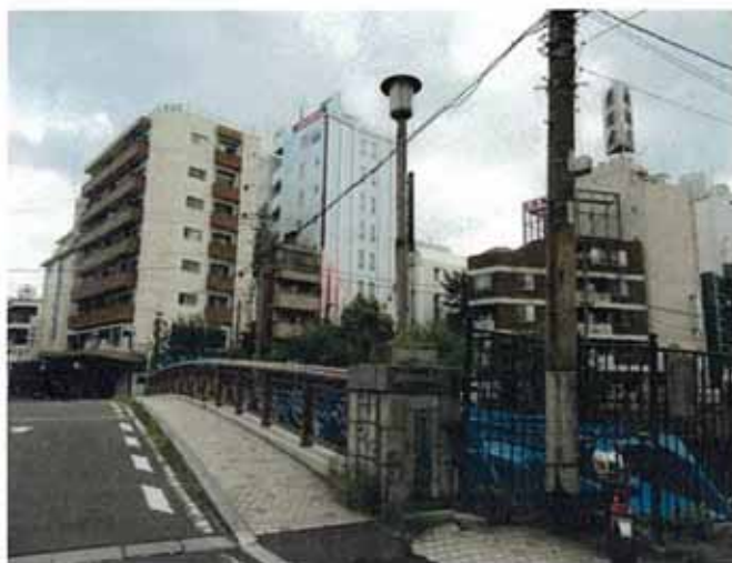
宮川橋の親柱
