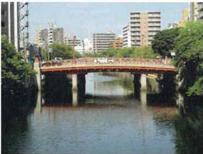
6 太田橋（現存）＜長さ：27.1m、幅：22.0m＞
