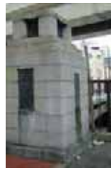
西の橋の親柱
