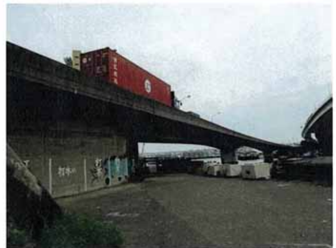
新山下橋（下流）
