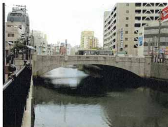
3 長者橋（現存）＜長さ：27.0m、幅：21.8m＞
