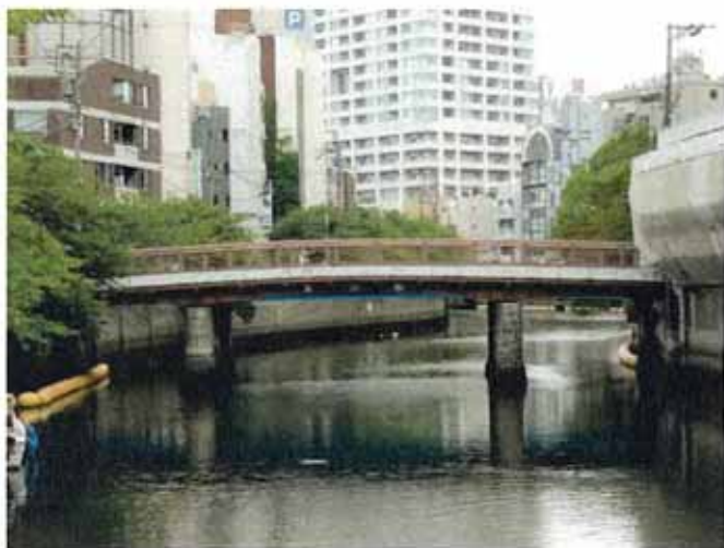
2 宮川橋（現存）＜長さ：27.1m、幅：7.5m＞
