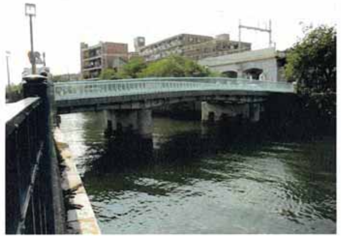
7 道慶橋（現存）＜長さ：27.1m、幅：7.32m＞
