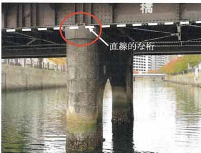
旭橋の主桁の例
