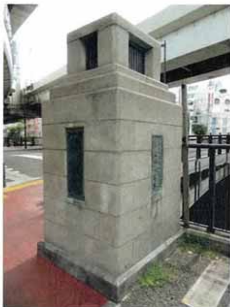
西の橋の親柱
