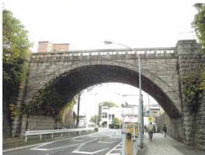
桜道橋（現存）＜長さ：14.8m、幅：6.3m＞ （横浜市認定歴史的建造物、選奨土木遺産）
