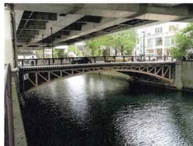
12 谷戸橋 (現存) <長さ: 29.0m、幅: 15.0m> (横浜市認定歴史的建造物、選奨土木遺産)
