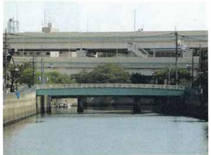
山王橋人道橋
