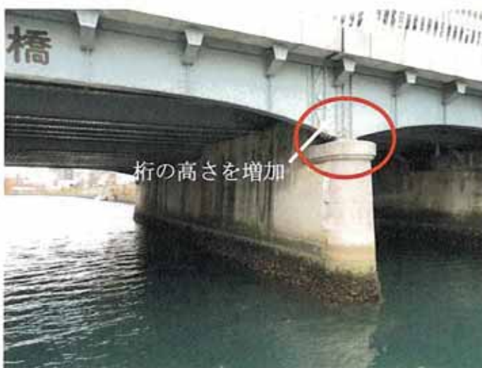
一本橋の主桁の例
