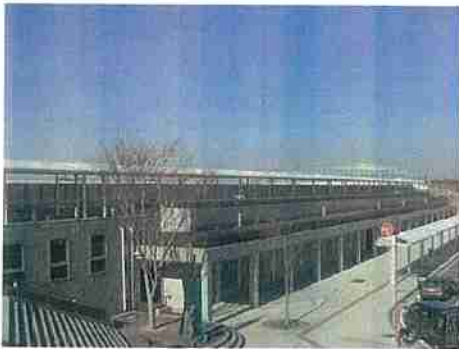
屋上緑化された駐輪場(石岡市)
