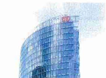
屋根デザインにより設備類を隠す方法(ベルリン)
