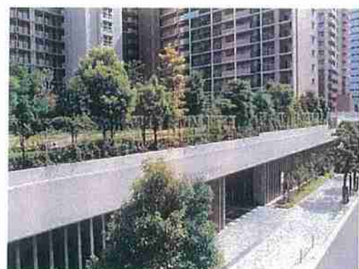
通りの連続性や緑の連続性をとぎれないように駐車場の出入口を設けた例(港区)
