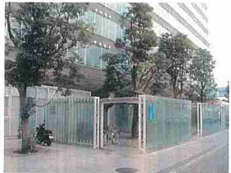
緑と半透過性素材によって軽快に仕上げている駐輪場(渋谷区)
