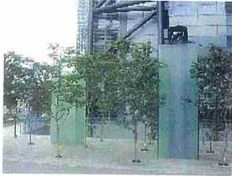
吸排気等を建物外壁と同様なガラスで修景した例(港区)
