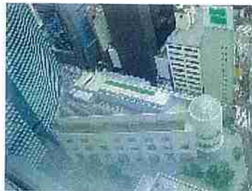
上方からの見え方にも配慮した設備類の修景(港区)
