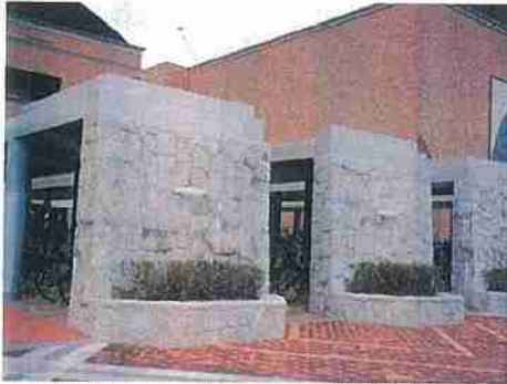
建物と調和した工作物によって駐輪場を隠している例
