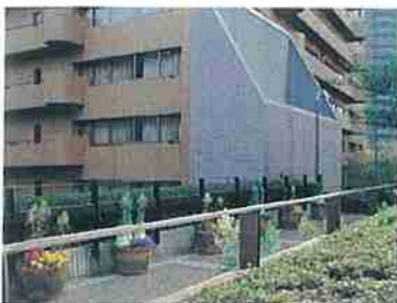
デッキ上のプランター（港区）
