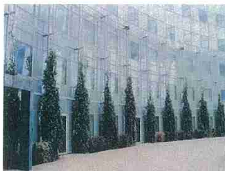
建物デザインと調和した軽快な素材の誘因施設によるカーテンウォールの緑化(パリ市)
