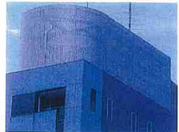
機器をルーバーにより隠す方法(文京区)
