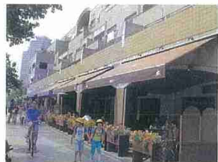
住宅の低層部にオープンテラスの店舗を連続的に配置し、歩行空間のにぎわいを創出している例(港区)
