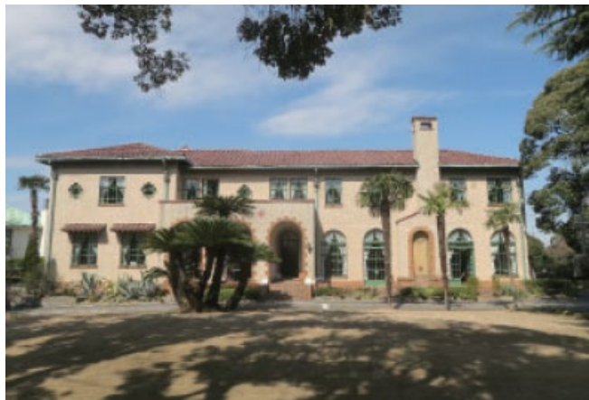
▲ベーリックホール
