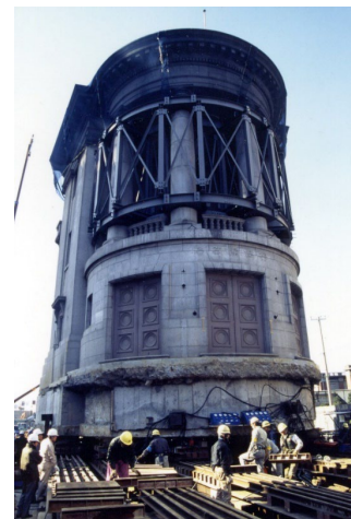
▲旧横浜銀行本店別館 (曳家移築により保全)
