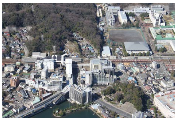
金沢八景駅東口地区土地区画整理事業（完了）
