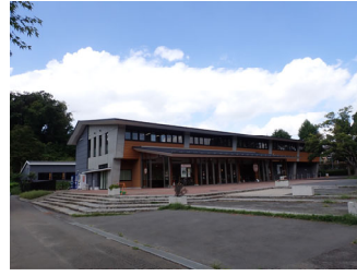
◆建築物は周囲の木々を越えない高さに抑え、公園の景観に馴染ませています (旭区大池町/こども自然公園)
