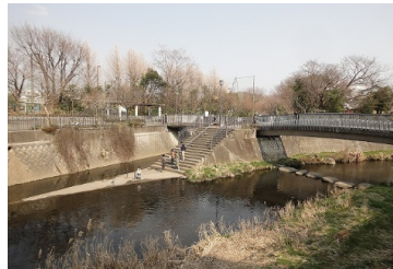
◆堤防から水辺に降りる階段を整備し、水に触れあうことのできる空間が創出されています (栄区桂町／いたち川)
