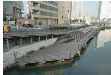
◆ウッドデッキのボードウォークが整備され、水辺を感じることでできる空間を創出しています (中区桜木町／大岡川河口付近)
