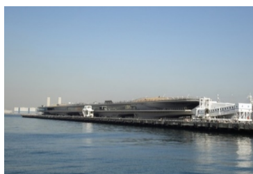
◆ 先進的なデザイン の採用により、港のランドマークとなっています (中区海岸通り ／大さん橋国際客船ターミナル)
