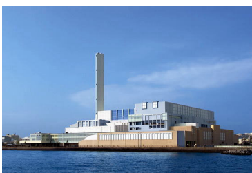
◆建築物の外壁の彩度を抑えた色彩とすることで、 海の青色と調和 しています (金沢区幸浦／金沢工場(ごみ焼却工場))
