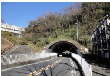
◆坑口部壁面のコンクリート面を少なくすることで、 緑豊かな印象 を与えています (金沢区能見台／能見台トンネル)
