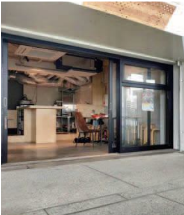
1階と2階それぞれが開いていて内部の階段で行き来するつくり
