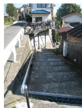
階段の手すり設置
