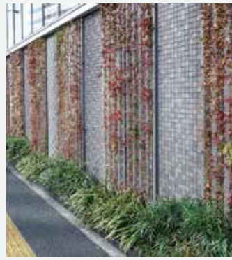
〈太田町6丁目〉 壁面緑化により沿道空間に潤いを創出している例
