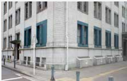
〈日本大通〉 壁面の一部の意匠として必要最小限の壁面看板をデザインした例
