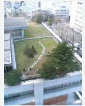
〈山下町(山下公園通り)〉 屋上緑化により空間に潤いを創出している例
