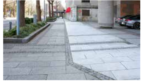
〈山下町〉 歩道と同調の素材・デザインで歩道状空地を整備した例
