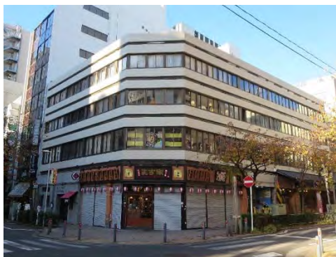
▲住吉町新井ビル3階（外観）
