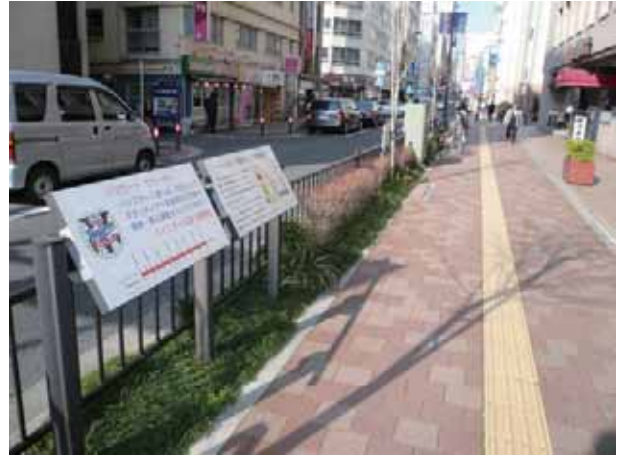
保水性舗装（ベ이스タース通り）
