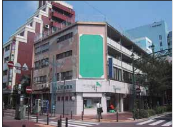
戦災復興ビルなどの建物の更新・利活用が必要となっている
