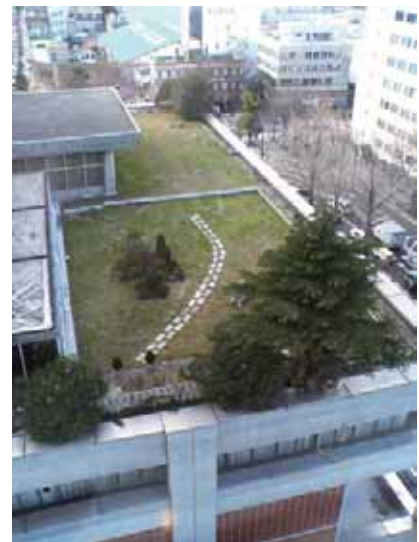
屋上緑化の例
