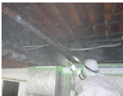
アスベスト含有建材除去イメージ
