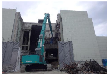
枠組養生足場、重機解体イメージ
