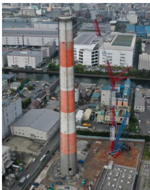
煙突解体全体イメージ
