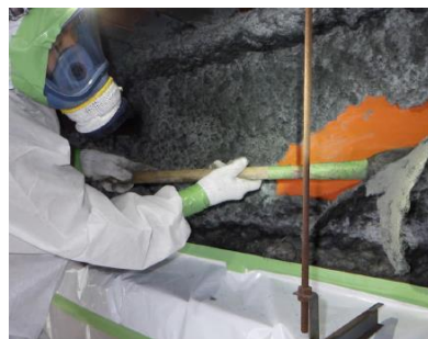
アスベスト含有建材除去イメージ
