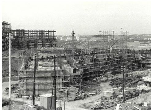
建築工事中の写真① 2-5号棟（地域住民提供）
