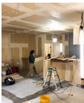
工事中的様子
