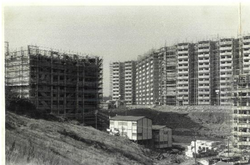
建築工事中の写真② 奥が1-1号棟（地域住民提供）
