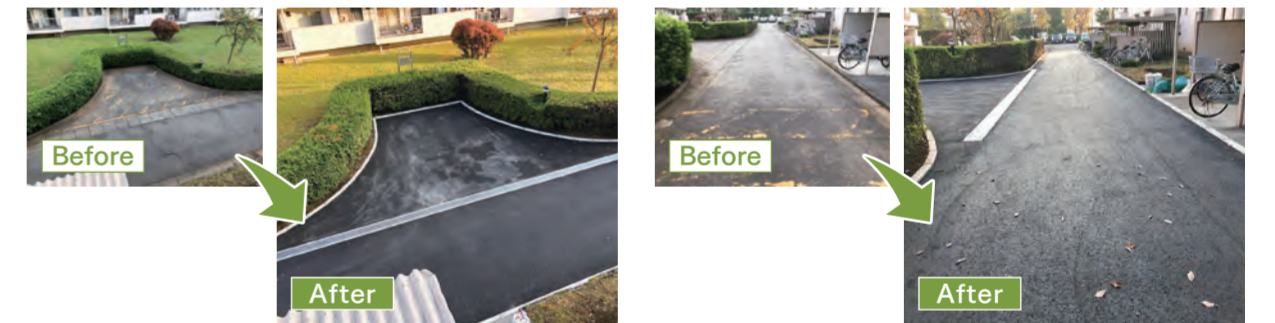
住棟北側歩道の段差をなくし、バリアフリーに
