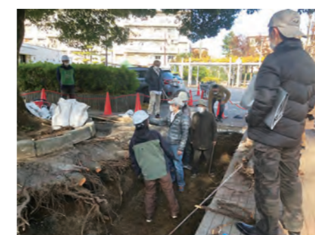
現地説明会にて工事内容を説明
