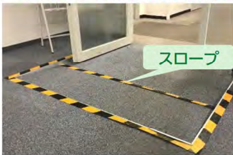
<管理事務所入口のスロープ>
