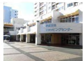
視認性が高い事務所のエントランス
