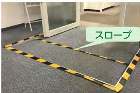
<管理事務所入口のスロープ>
