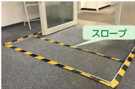
<管理事務所入口のスロープ>
