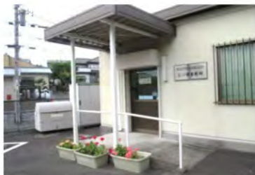
事務所入口にはスロープと手摺りを設置
