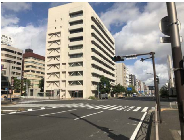
沿道建築物の耐震化
