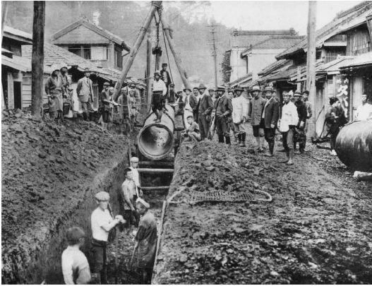
配水管（36インチ鑄鉄管）布設工事
