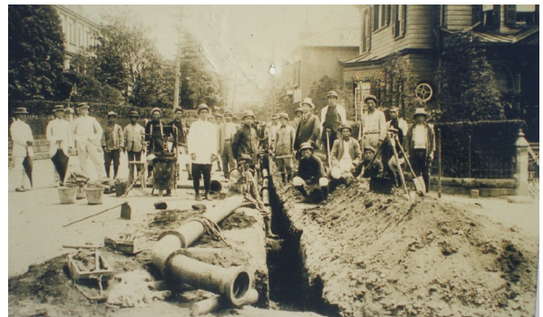
山手地区配水管工事
