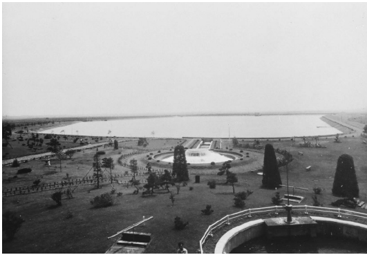
相模原沈殿池
