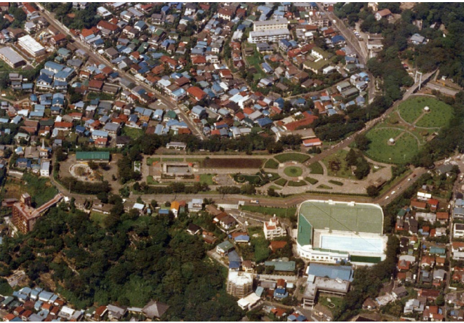
新野毛山配水池
