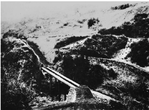
複管化が完了した導水路
