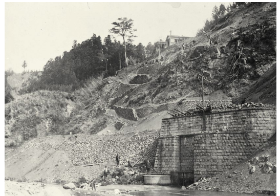
崩壊した鮎子取入口（土木学会「関東大地震震害調査報告 第2巻」より）
