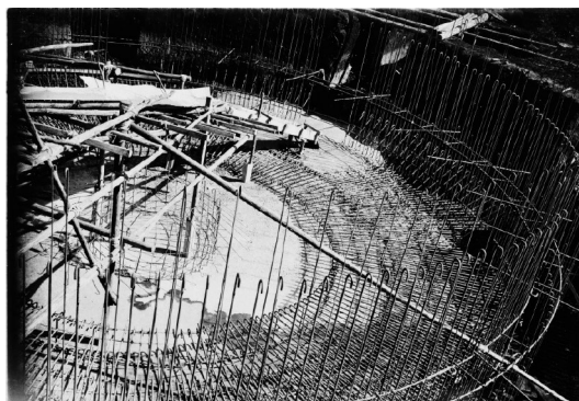
麻溝減圧水槽の基礎工事 1942（昭和17）年
