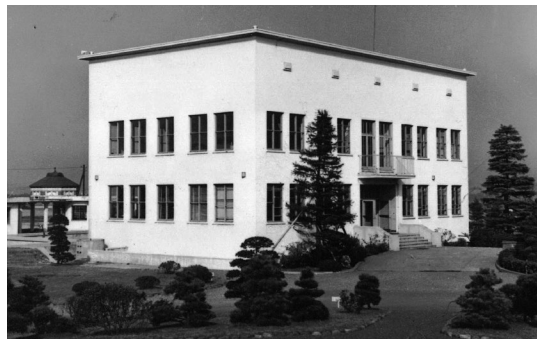
完成当時の西谷浄水場本館 1987（昭和62）年6月に改築し、横浜水道記念館として開館
