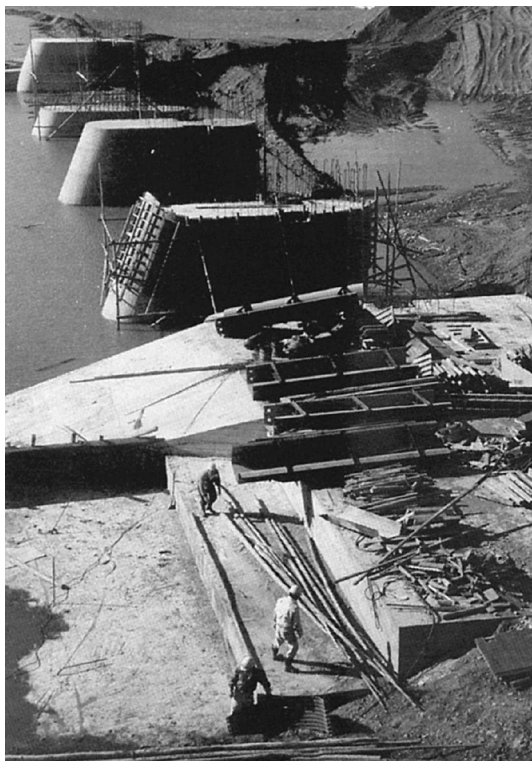
建設中の寒川取水施設
