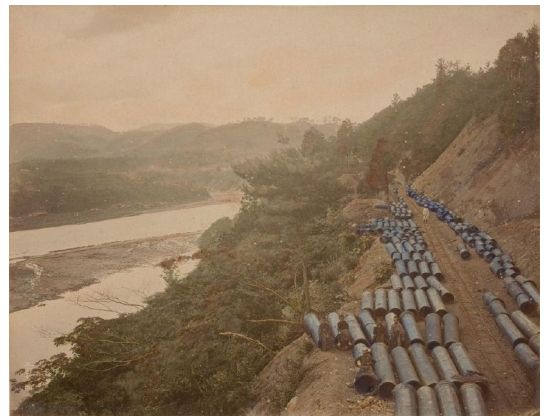
水道鉄管布設線路 (宮内庁書陵部所蔵「横浜水道写真帖」より)
