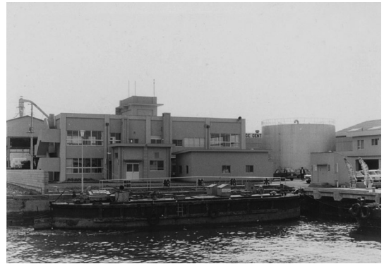
本牧埠頭に移転した船舶給水営業所
