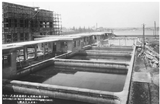
建設中の西谷浄水場急速濾過池
