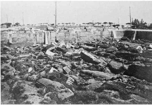
野毛山浄水場の被害状況（土木学会「関東大地震震害調査報告 第2巻」より）
