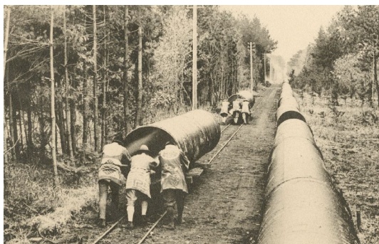
口径1,100mm 鑄鉄管の運搬
