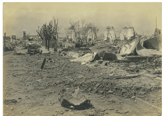
山下町水町通りの被害状況
