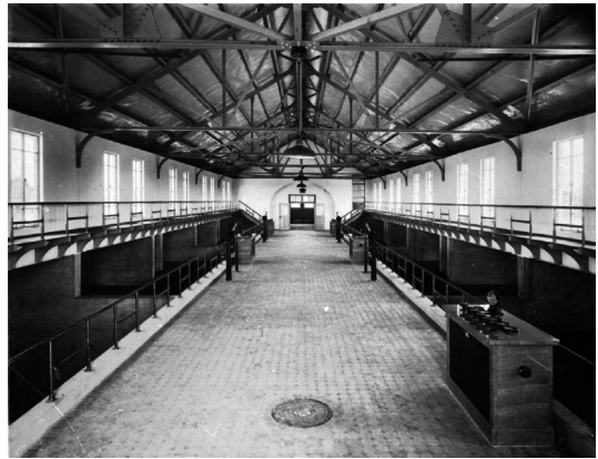
西谷浄水場急速濾過池
