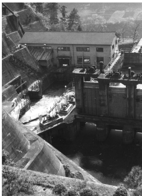
津久井分水池入口
