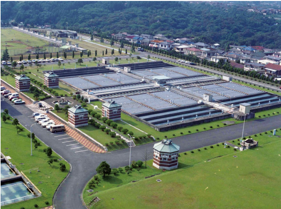
西谷浄水場沈殿池
