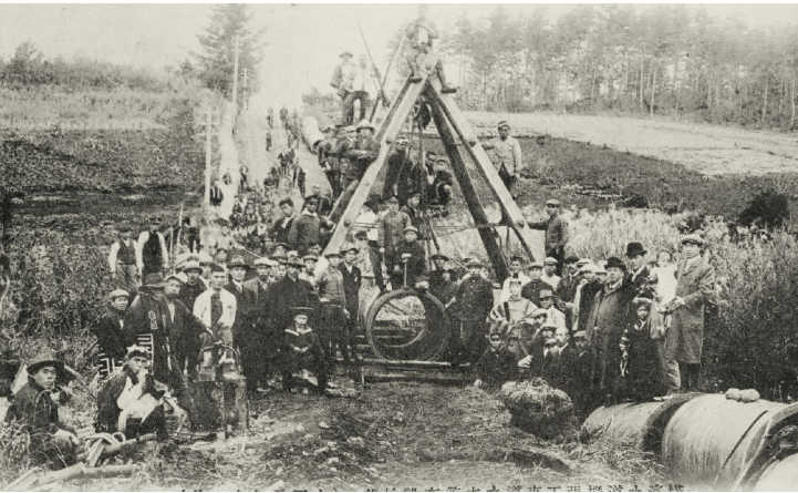
導水本管布設工事
