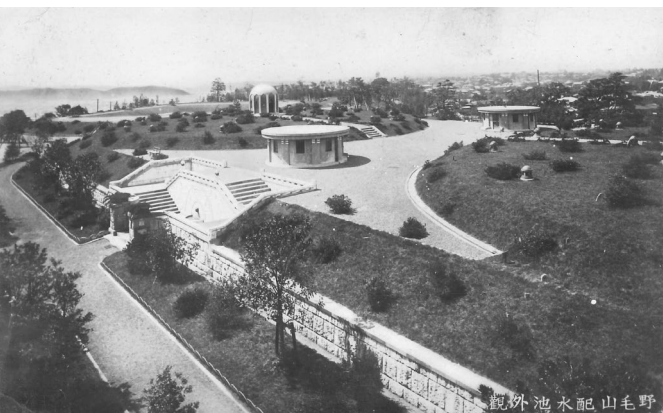
野毛山浄水場跡に完成した野毛山配水池
