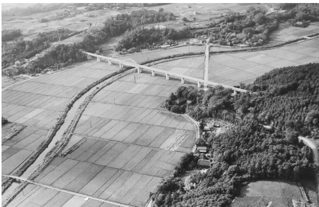
引地川水路橋
