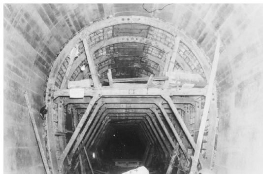
導水隧道建設工事
