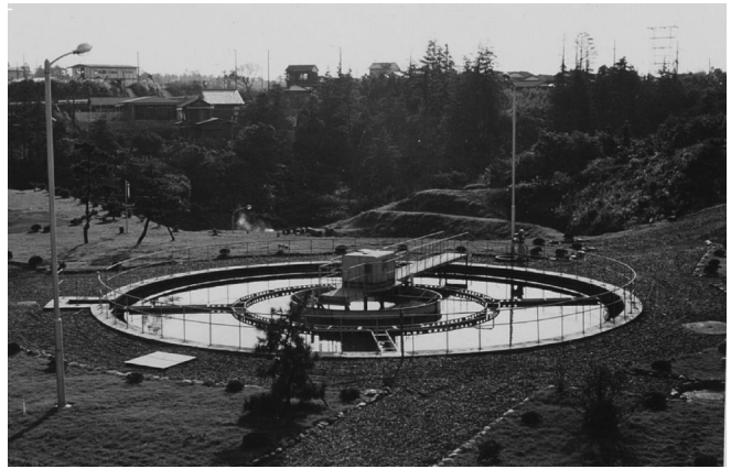
西谷処理場高速凝集沈殿池
