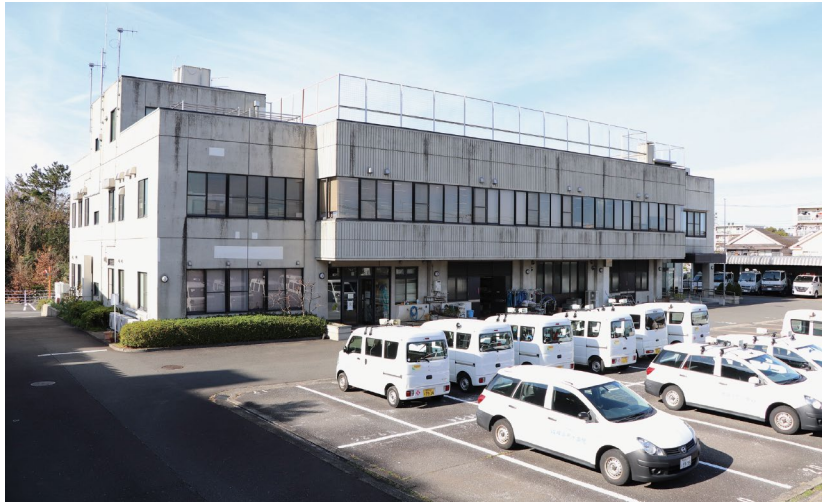
洋光台水道事務所
