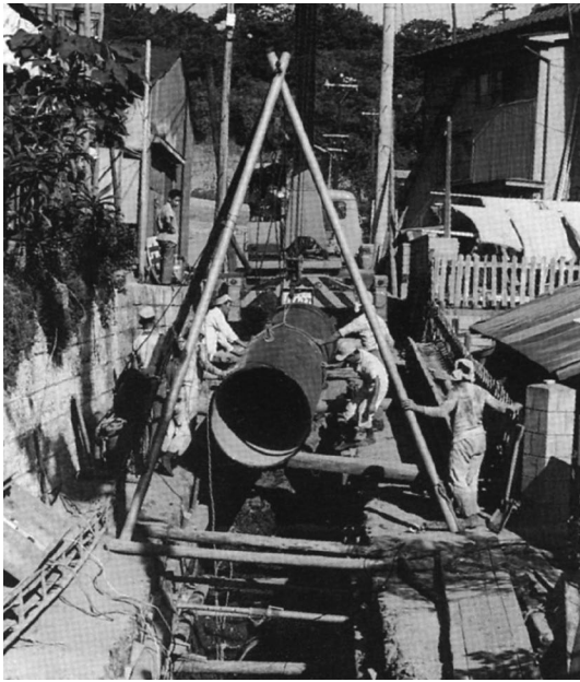
口径1,000mm配水管布設工事（鶴見区東寺尾町）
