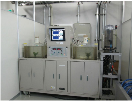
自動水質監視装置
