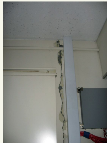
関内中央ビルの内壁の状況
