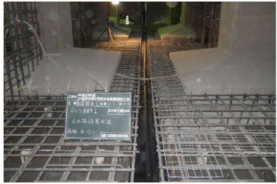
小雀2号配水池耐震補強工事
