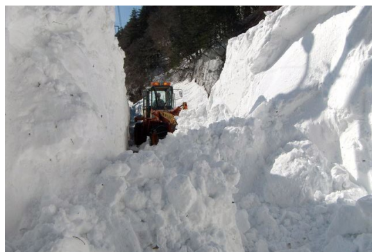
雪崩に見舞われた村内の国道 2014(平成26)年
