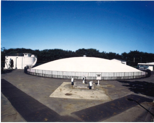
東寺尾配水池
