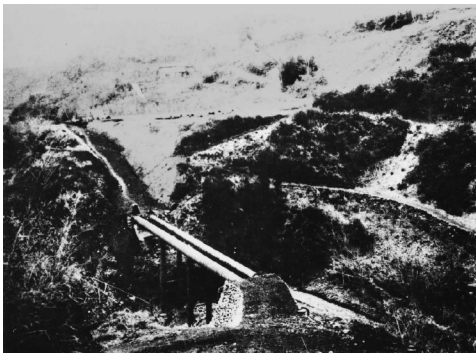
複管化が完了した導水路
