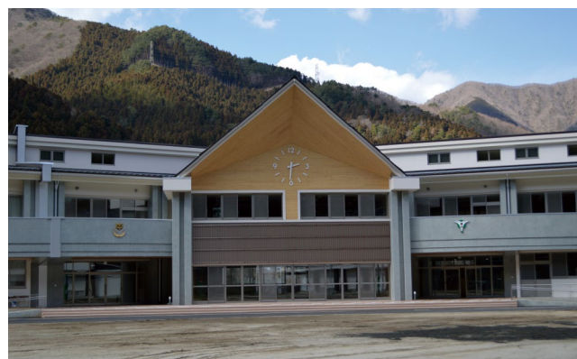
完成した道志小・中学校新校舎
