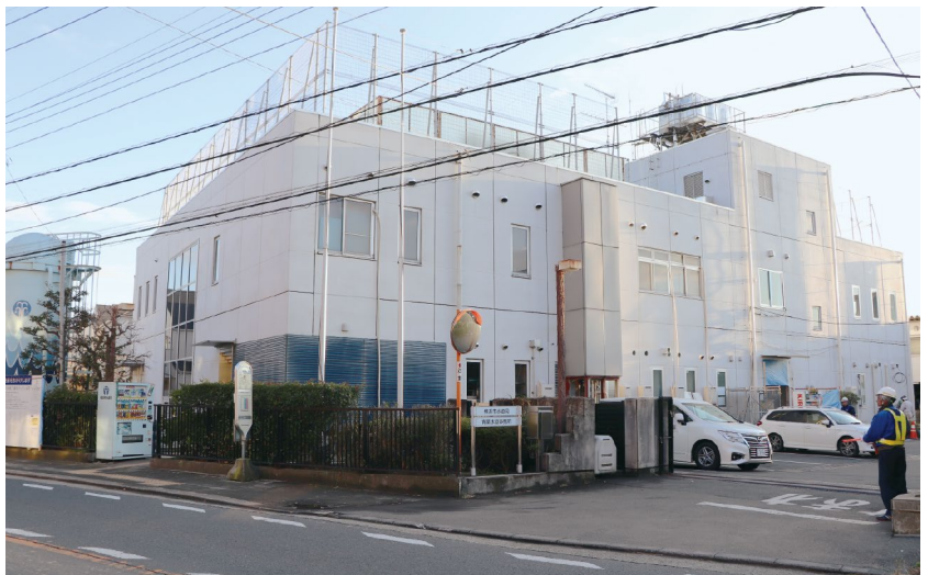
青葉水道事務所
