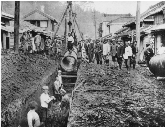
配水管（36インチ鑄鉄管）布設工事
