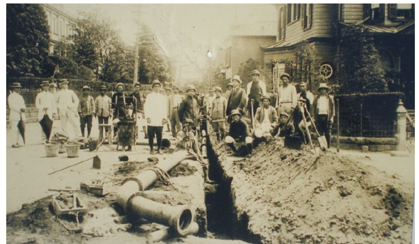
山手地区配水管工事
