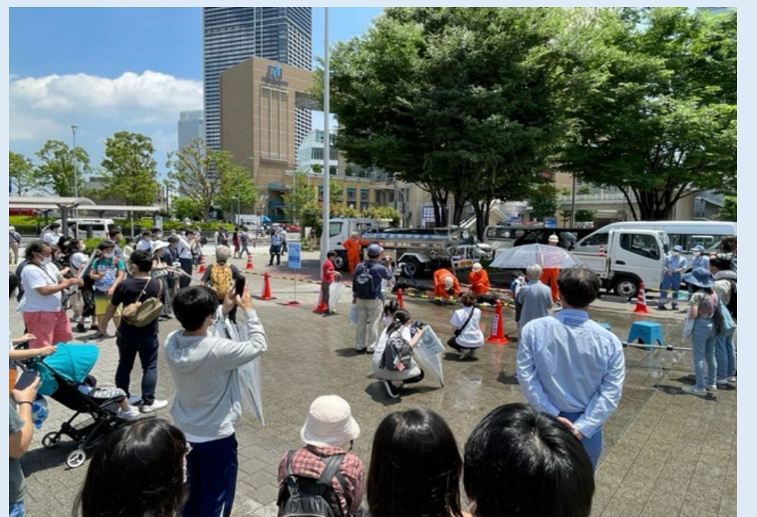
普段は地中に埋まっている水道管も間近で見学。
