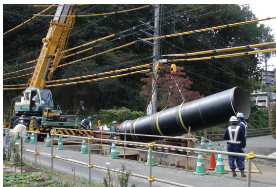
古くなった水道管の取り替え工事
