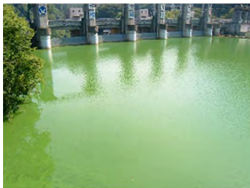
図 2.2.5 相模湖堰堤付近のアオコ発生状況 (平成 20 年 8 月)
