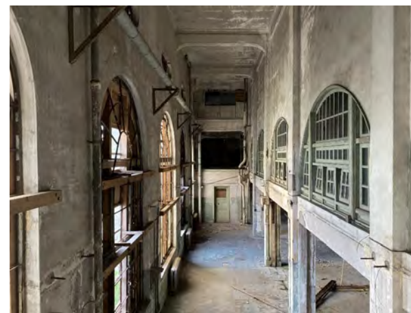
◀ 3、4階通路吹抜け部分
