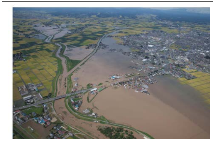
平成27年関東・東北豪雨で起こった大規模な水害
