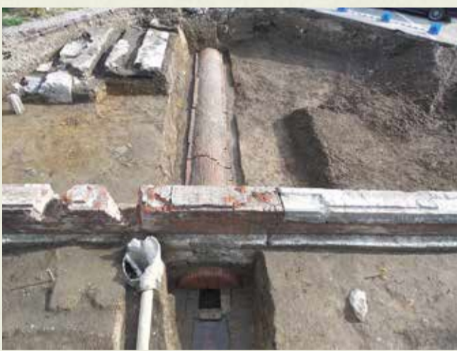
煉瓦造倉庫の基礎とその下に埋設された導水管
