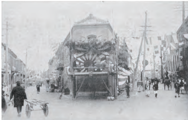
▲ 開港50年祭の中華街 1909年7月 横浜開港資料館所蔵 左が中華街大通り。右の通りは現在の開港道。 中央の建物は、現在の山下町交番の位置にあたる
