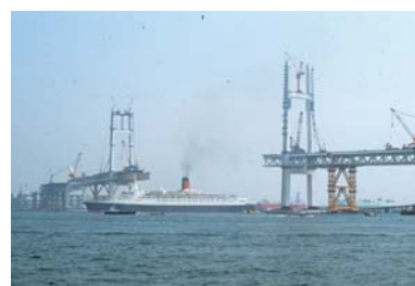
建設中の横浜ベイブリッジ 1988(昭63)年 下を通るのはクイーンエリザベス2世号
