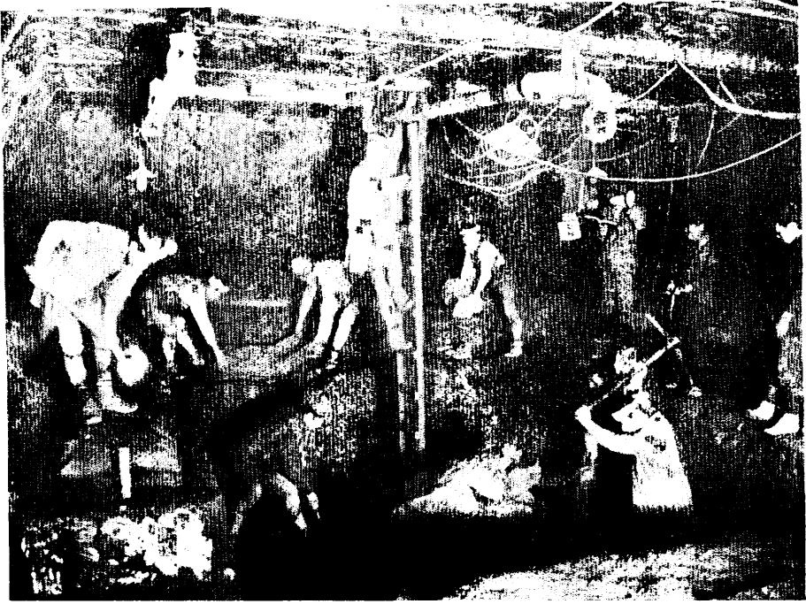
税関ふ頭の建設工事〈大正6年〉
