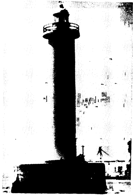
代表的な航路標識の灯台（本牧防波堤）
